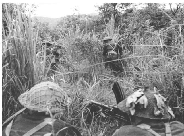
武装掩护筑路
