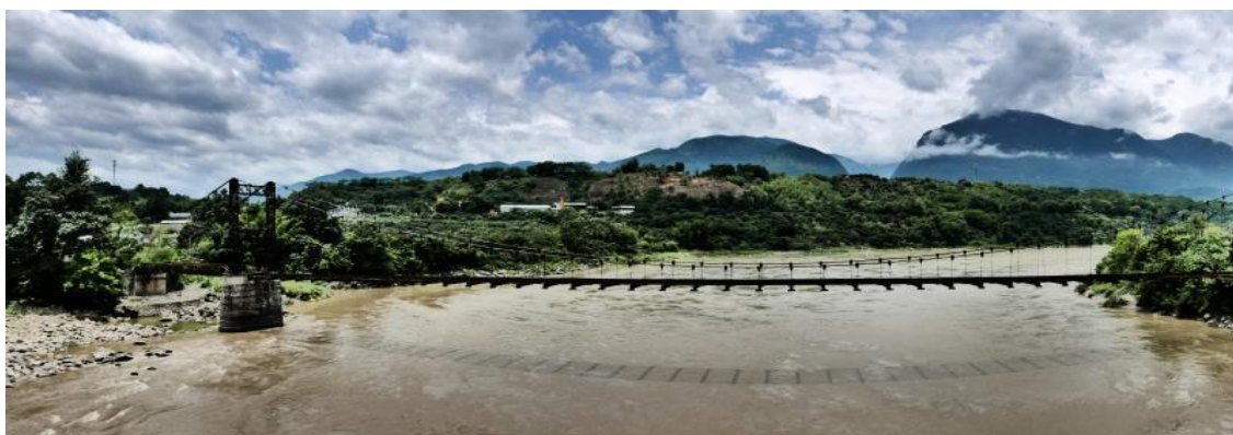
横跨怒江两岸的继成桥
