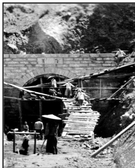
修筑中的滇缅铁路
